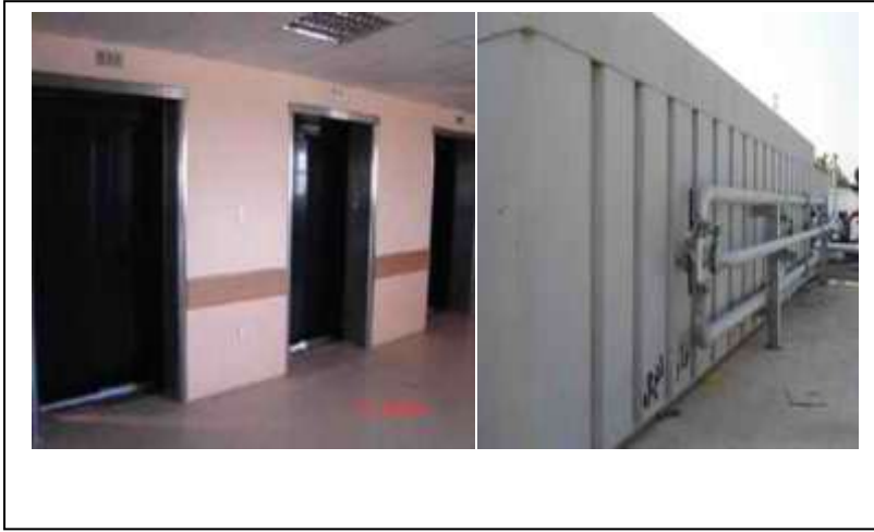
تأهيل بنائة الخدمات المركزية والمساعد لمجمع مدينة الطب
